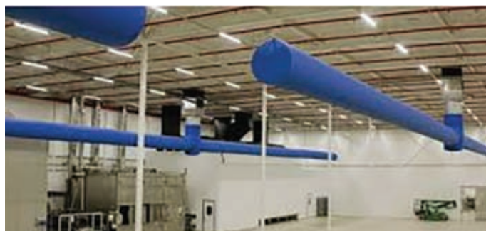
Příklad vnitřního rozvodu chladného vzduchu ukazuje systém rovnoměrné distribuce pro efektivní chlazení prostor.
